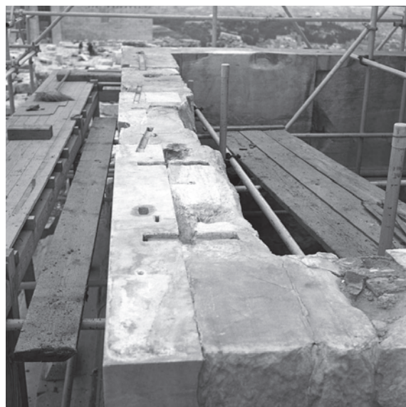
Φωτ. 382. Οι εντορμίες μορφής Π στον λίθο 532 του ορθοστάτη της νότιας πρόστασης. Α. Παπανικολάου, Νοέμβριος 1979.
