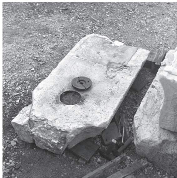
Φωτ. 383. Η εντορμία και ο σιδηρός αμφιγόμενος στον λίθο 522 του ορθοστάτη της νότιας πρόστασης. Α. Παπανικολάου, Νοέμβριος 1979.
