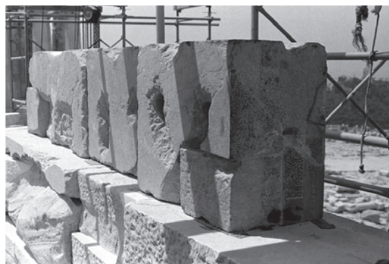
Φωτ. 397. Οι αποκατεστημένοι λίθοι 208, 209, 210 της ζωφόρου του δυτικού τοίχου. Αποψη από βορειοανατολικά. Π. Ψάλτης, Μάιος 1985.
