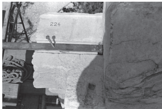
Φωτ. 393. Ο άβακας 224 του κιονοκράνου του δυτικού τοίχου της ρωμαϊκής επισκευής. Άποψη εκ των άνω. Στην άνω έδρα του διακρίνεται η νέα δοκός από τπάνιο. Α. Παπανικολάου, Ιούνιος 1985.
