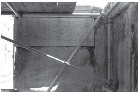
Φωτ. 381. Συμπλήρωμα από νέο μάρμαρο στο ανώτερο τμήμα του λίθου 533 του ορθοστάτη του βάθρου της νότιας πρόστασης. Α. Τζάκου, Απρίλιος 1976.
