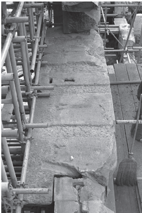
Φωτ. 386. Ο λίθος 663 του ανωφλίου του βόρειου θυρώματος. Διακρίνεται στο δυτικό άκρο η αρχική διαμόρφωση σχήματος Γ. Α. Παπανικολάου, Σεπτέμβριος 1981.
