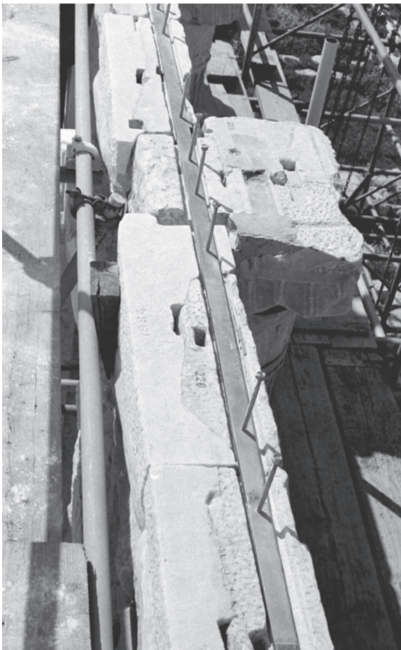
Φωτ. 395. Οι λίθοι 219, 220, 221 του δυτικού τοίχου αποκατεστημένοι. Α. Παπανικολάου, Μάρτιος 1985.
